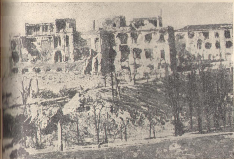
Зруйновані під час боїв будівлі в Університетському городку на Мадридському фронті.
